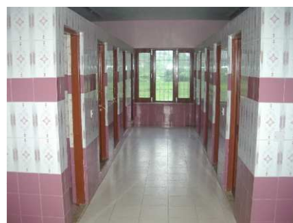
Les salles de bains équipées de chauffe-eaux
